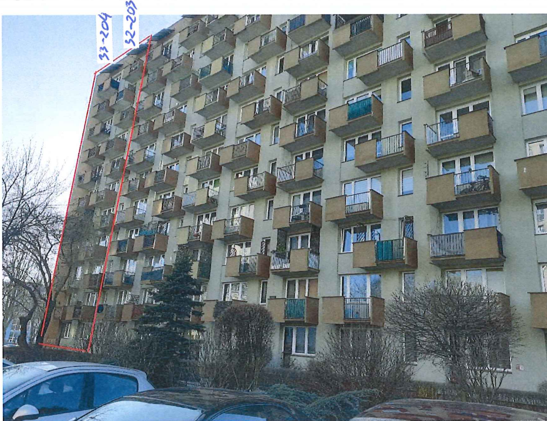
ul. Stachiewicza 35, Kraków, elewacja WSCHODNIA, 2 piony
